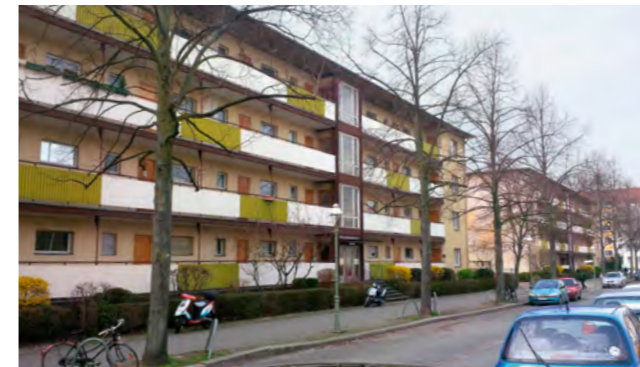
Ist-Zustand Heidelberger Straße
